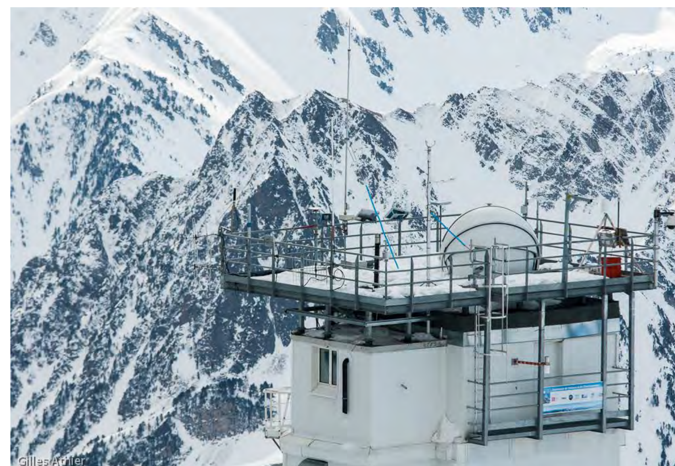
Plateforme pyrénéenne d'observation atmosphérique (P2OA) : site du Pic du Midi Photo : ©F. Gheusi (LA)
